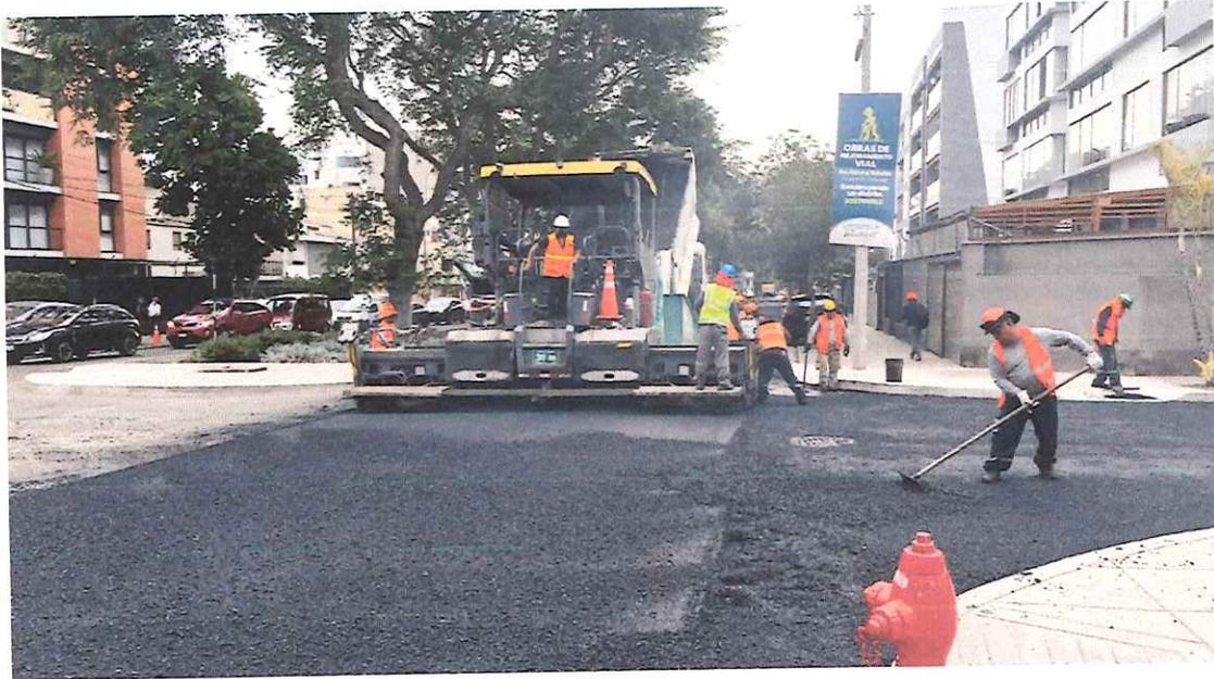
Espaciadora y cuadrilla del tren de asfalto en el tendido de la carpeta asfáltica y así mismo se aprecia su acabado con el apoyo de los rodillos tándem y neumático.
