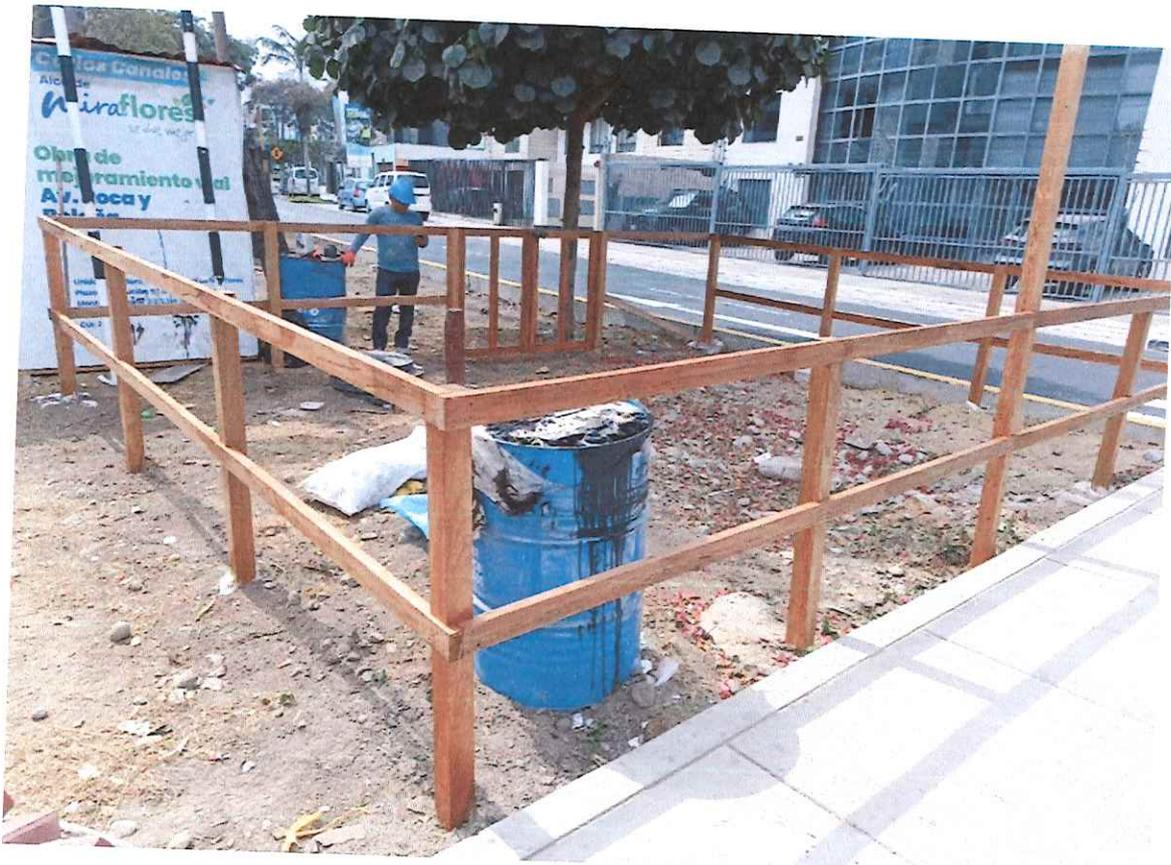
Se aprecia instalación del cerco de madera y cartel de acopio de maleza, según indica los planos.
