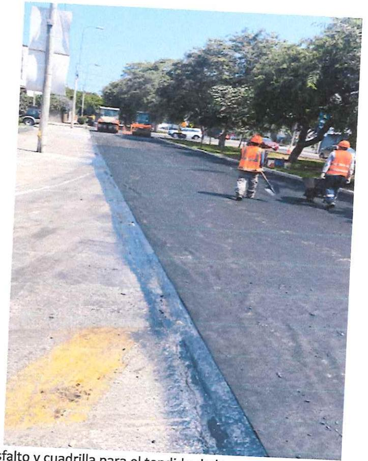
Tendido del geotextil no tejido, extendedora de asfalto y cuadrilla para el tendido de la carpeta asfáltica e = 2"
