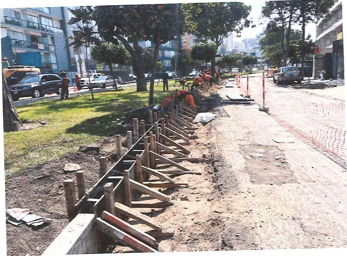
Encofrado de sardinel peraltado y así mismo vaciado de concreto y vibrado para la ampliación de vía.
