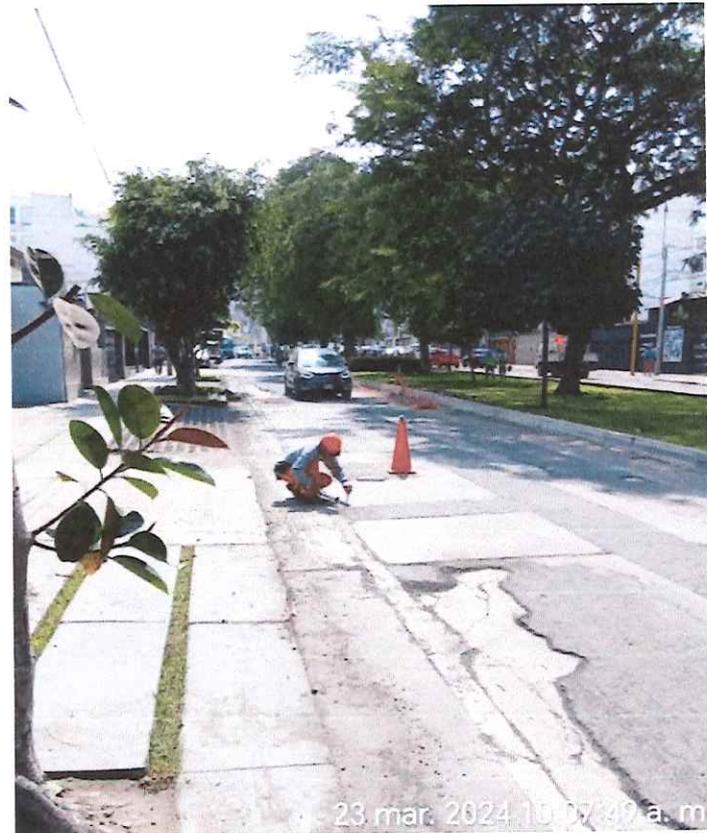
Se aprecia en las tomas fotográficas que se procede al sellado de fisuras en aditivo ELASTOMERICO según indicaciones del expediente técnico.
