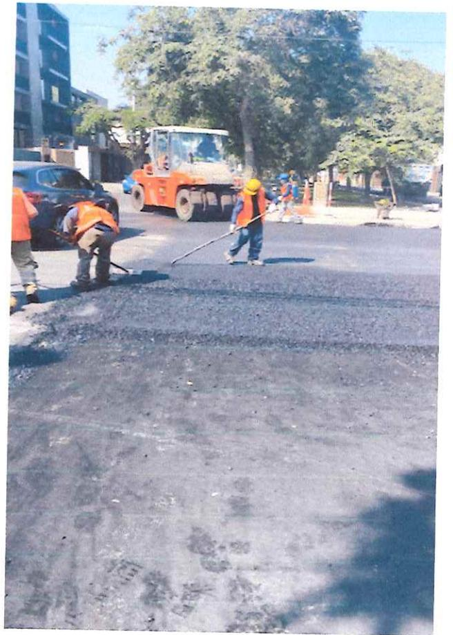
se aprecia en la toma fotográfica el inicio del tendido de la carpeta asfáltica de 2" y así mismo también muestra para la prueba marshal.
