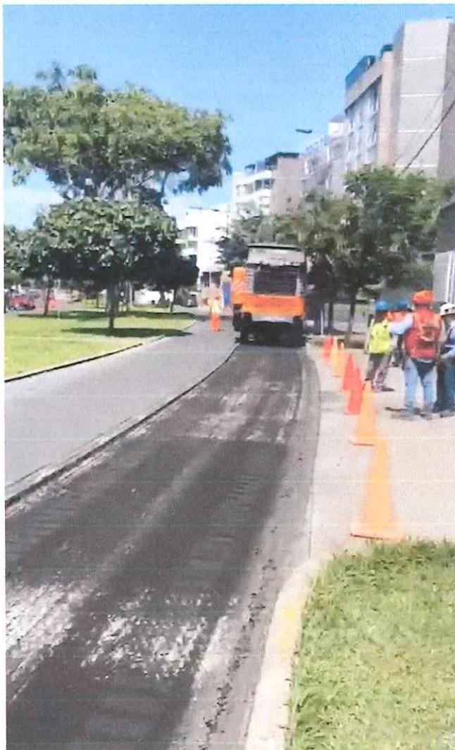
Se aprecia el fresado de calles en Av. Roca y Boloña y así mismo eliminación de material del fresado
