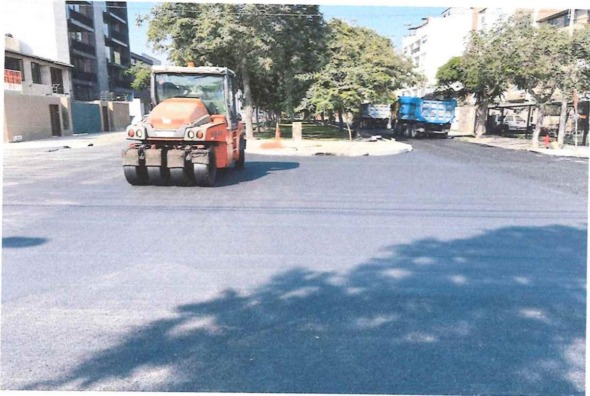
Se procede a la compactación de la carpeta asfáltica con rodillo neumático y así mismo preparación a nivel de base del bacheo profundo.
