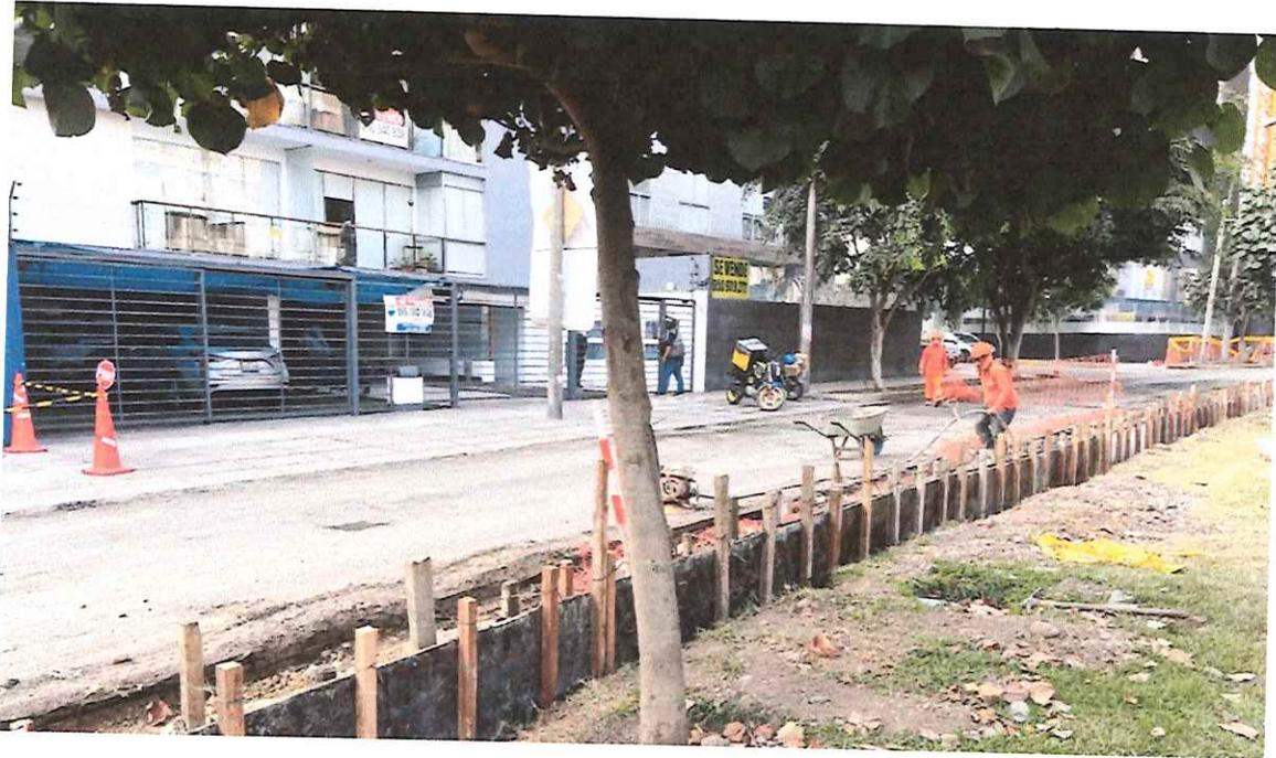
Se aprecia en la toma el vibrado del concreto de sardinel en ampliación de vía y así mismo conformación con material de préstamo (afirmado), para la ampliación de vía.
