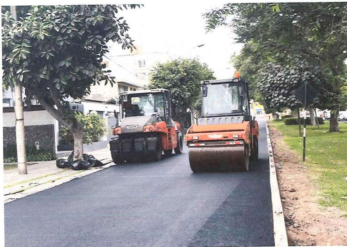
Se aprecia compactación de la carpeta asfáltica con ayuda del rodillo tandem y rodillo neumático para su acabado.
