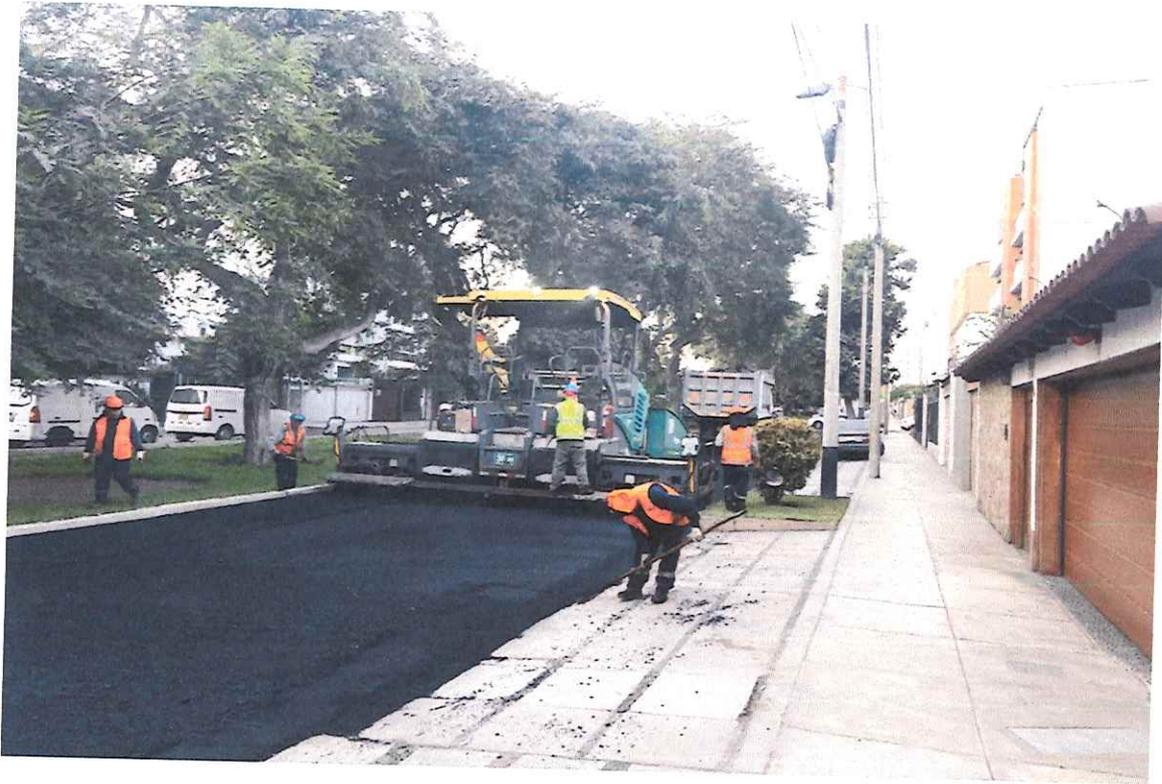
Se aprecia el tren de asfalto con la cuadrilla y así misma colocación del geotextil no tejido.
