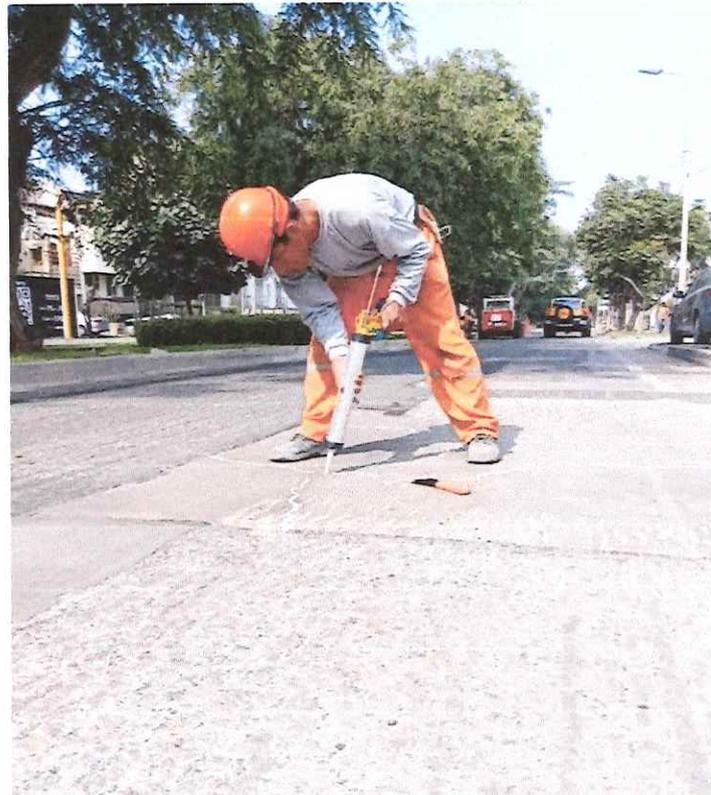
Se aprecia en las tomas fotográficas que se procede al sellado de fisuras en aditivo ELASTOMERICO según indicaciones del expediente técnico.
