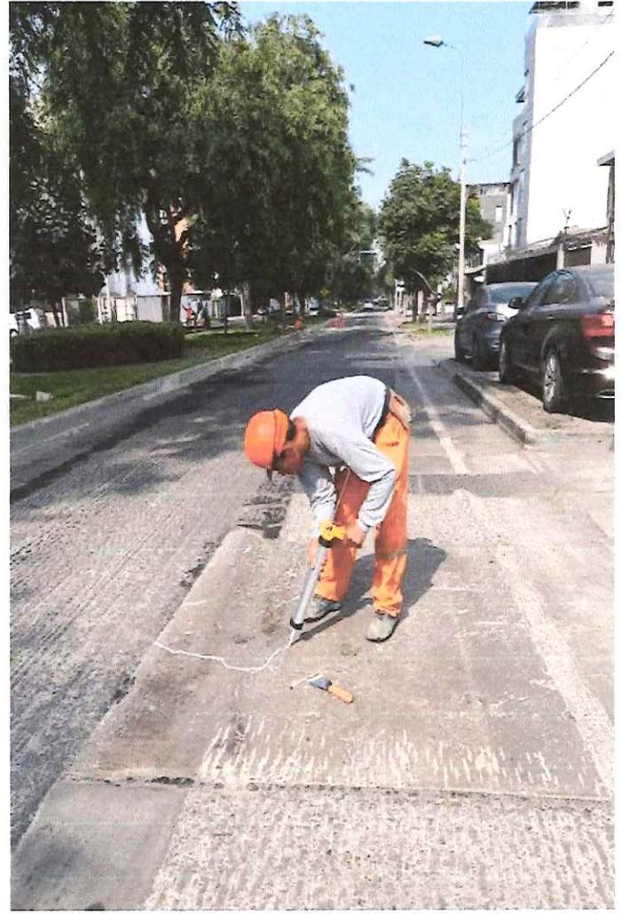
Se aprecia en las tomas fotográficas que se procede al sellado de fisuras en aditivo ELASTOMERICO según indicaciones del expediente técnico.
