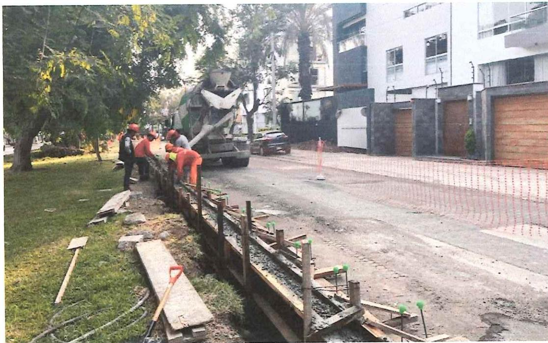
Se procede al vaciado concreto premezclado en sardinel en Av. Roca y Boloña.
