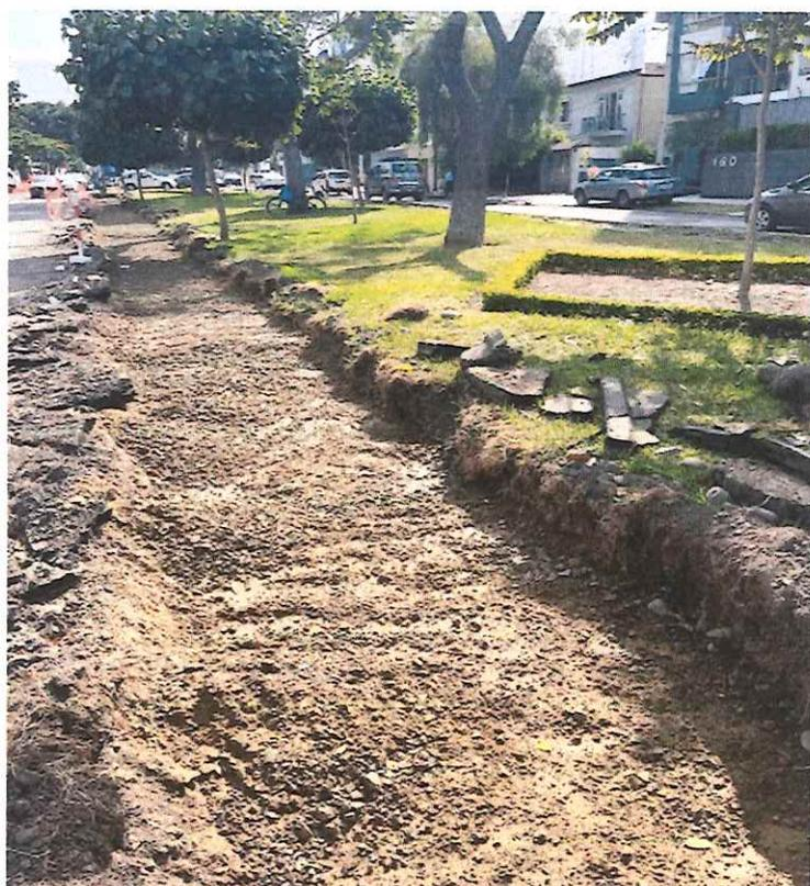
Se aprecia en la toma fotográfica que se procedió a la excavación para el ensanche de vía en cuadra 01 de la Av. Roca y Boloña y así mismo a continuación se procede a la conforma del material de préstamo y su compactación.
