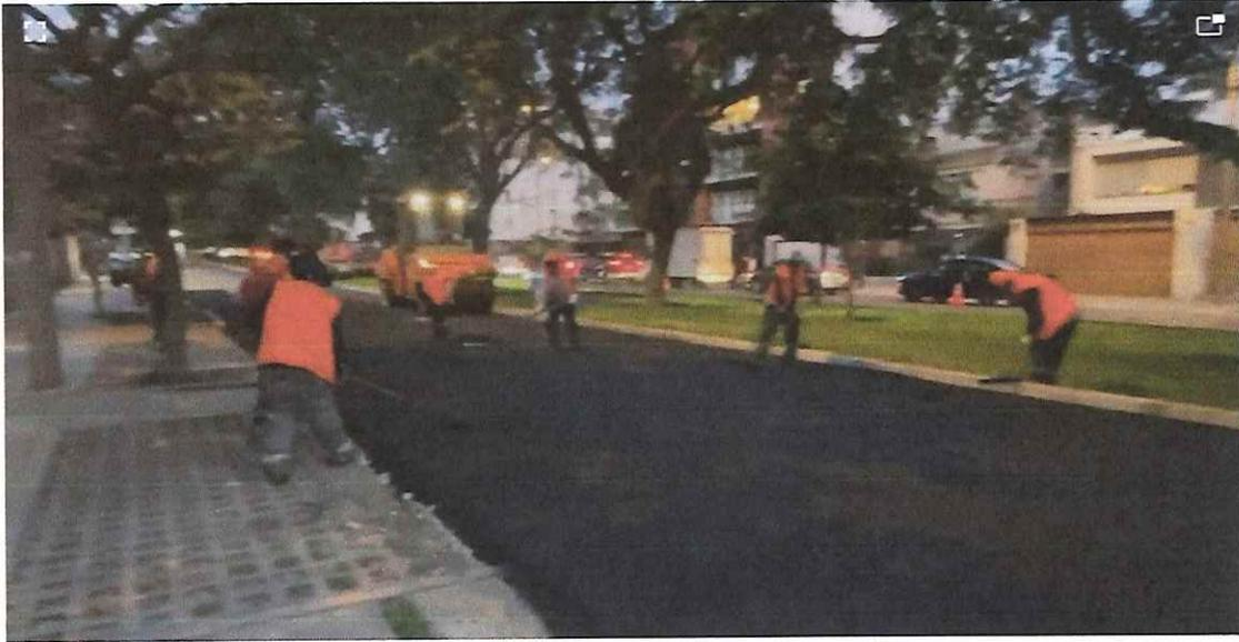
Se continua con el tendido de la carpeta asfáltica de E = 2" y se aprecia la cuadrilla del tren de asfalto.
