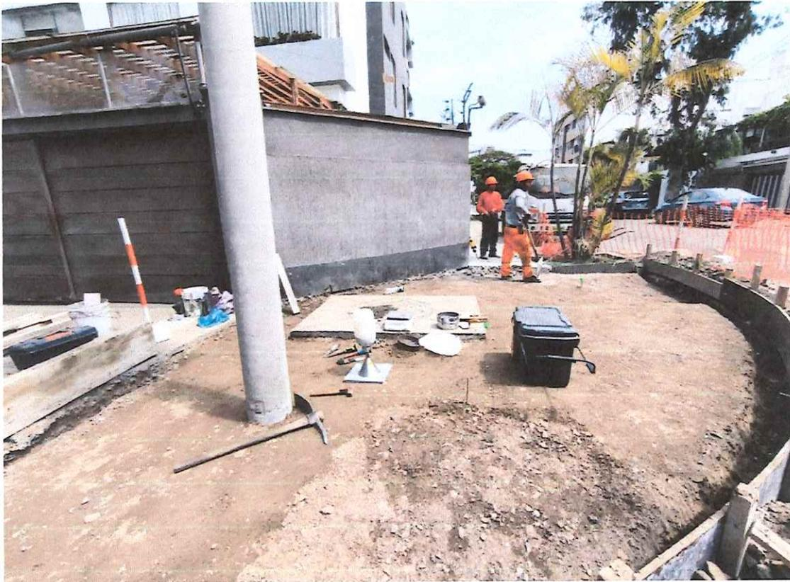
Se aprecia el equipo para dar inicio a las pruebas de las densidades de campo en martillos
