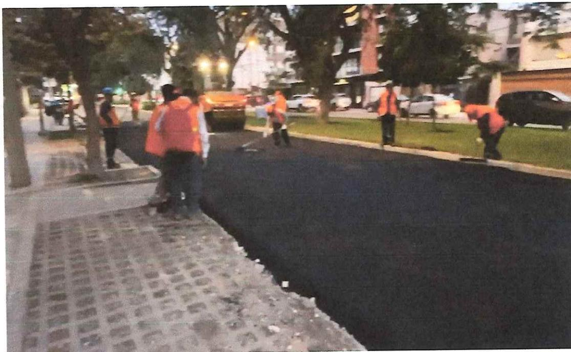
Se continua con el tendido de la carpeta asfáltica de E = 2" y se aprecia la cuadrilla del tren de asfalto.
