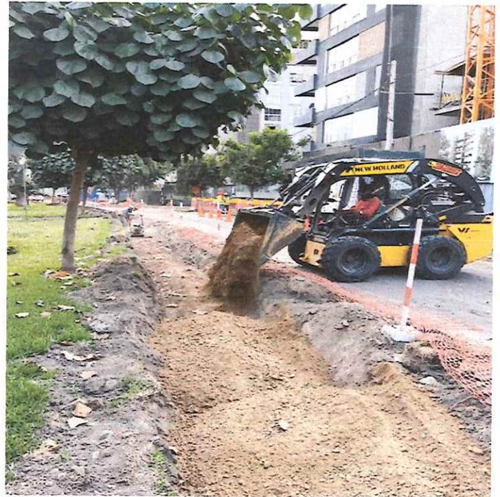
Se aprecia compactación de subrasante y relleno con material de préstamo afirmado para la ampliación de vía
