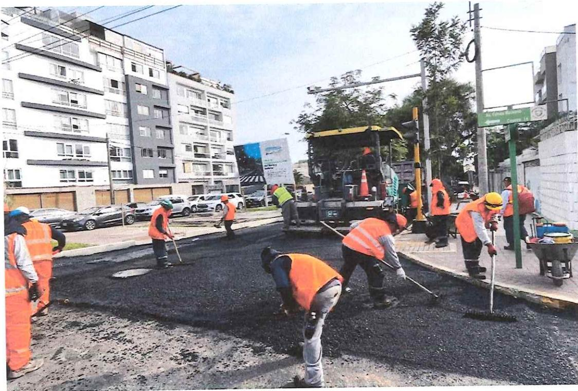
Se aprecia en las tomas fotográficas el inicio del tendido de la carpeta asfáltica, previo a ello colocación del geotextil no tejido, iniciando desde la cuadra 12 de la Av. Roca y Boloña, lado derecho.
