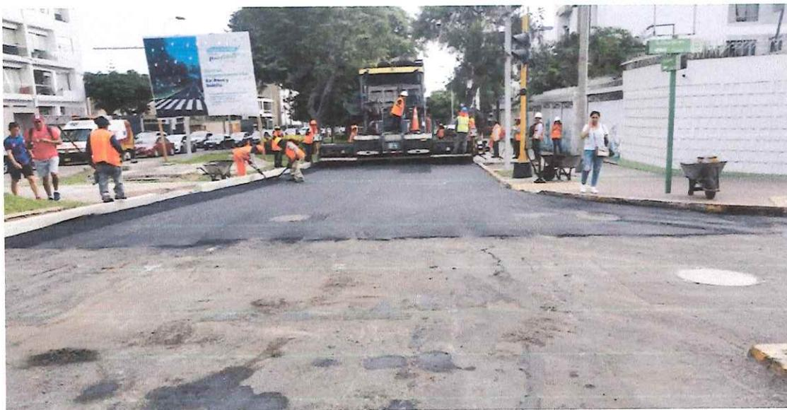
Se aprecia el inicio del tendido de la carpeta asfáltica en cuadra 12 de la Av. Roca y Boloña lado derecho y así mismo su acabado de la carpeta asfáltica en los bordes con las bermas laterales.
