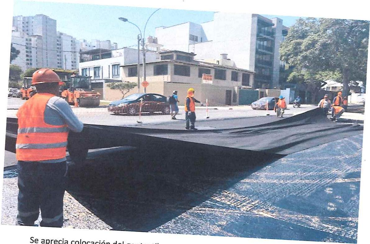
Se aprecia colocación del geotextil para en toda la vía incluido cruces de las calles.
