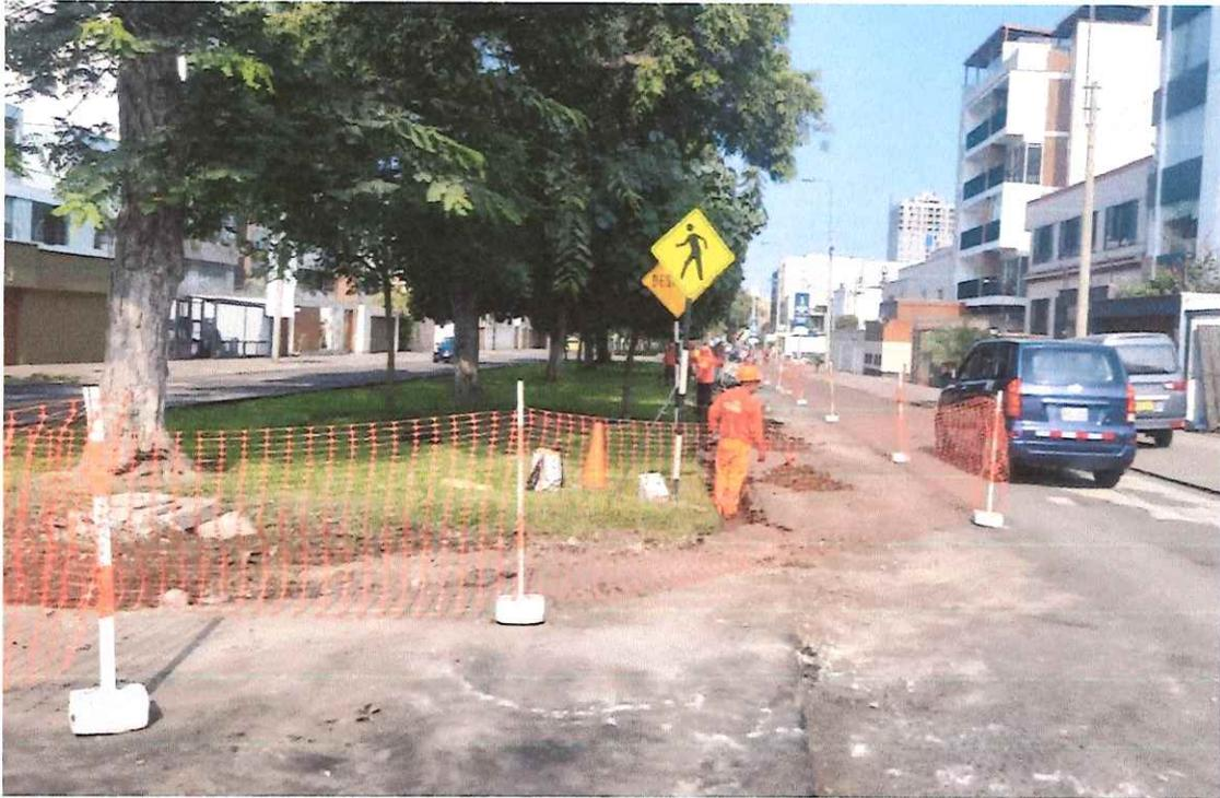
Según se refleja en la toma fotográfica, luego de las demoliciones de martillos existentes, se procede al acondicionamiento de las protecciones colectivas, añadiendo sendero mpeatonal.
