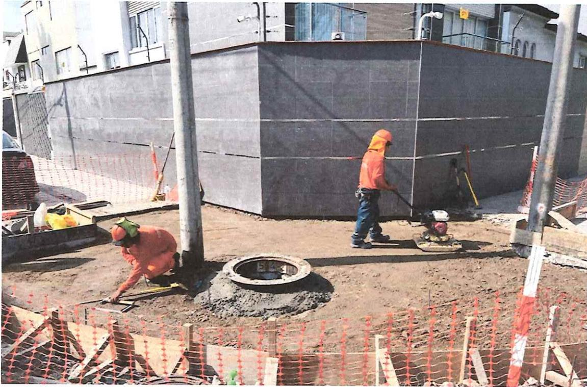
Se aprecia en las tomas fotográficas conformación y compactación del material de préstamo (afirmado a nivel de base) en martillos y bermas central.
