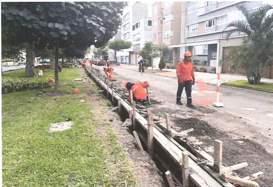
Se aprecia el acabado del vaciado de concreto en sardinel.
