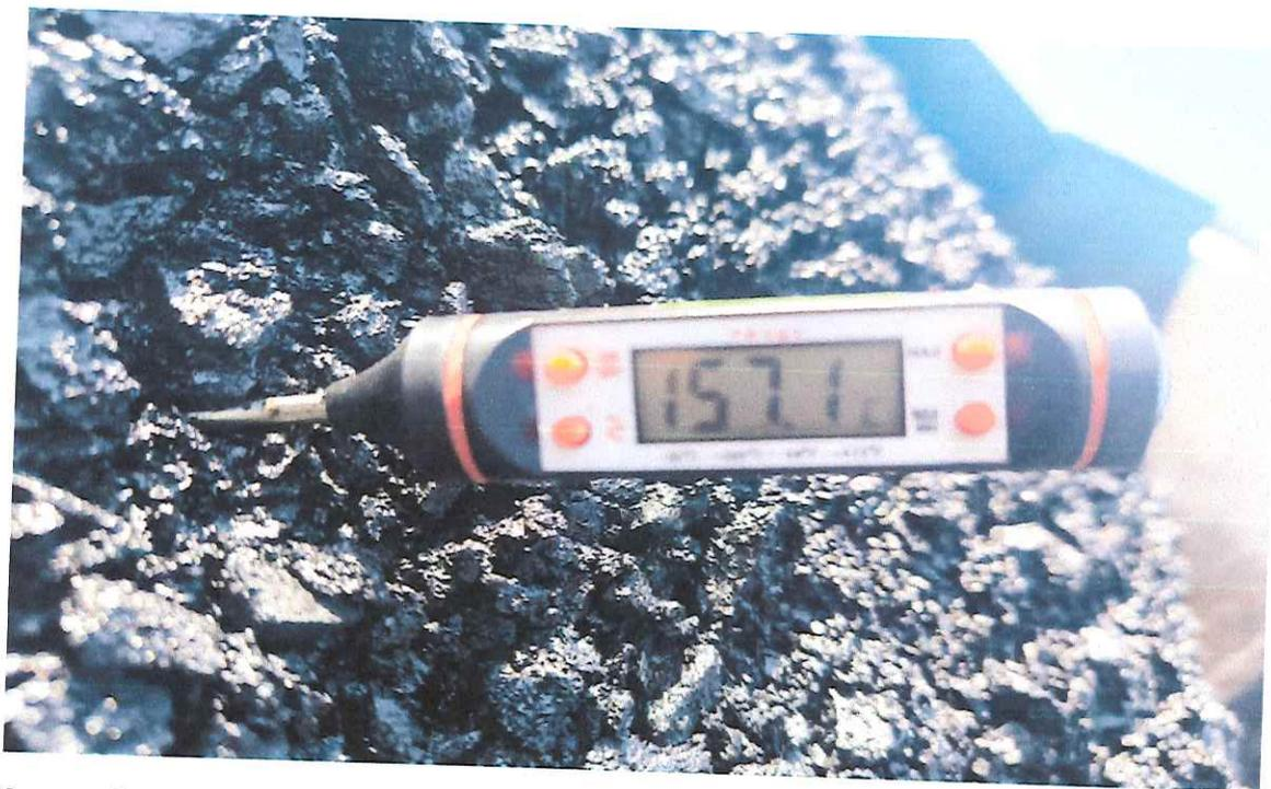
Se aprecia temperatura del asfalto de 157.10°, tendido del asfalto en laterales y rodillo neumático.
