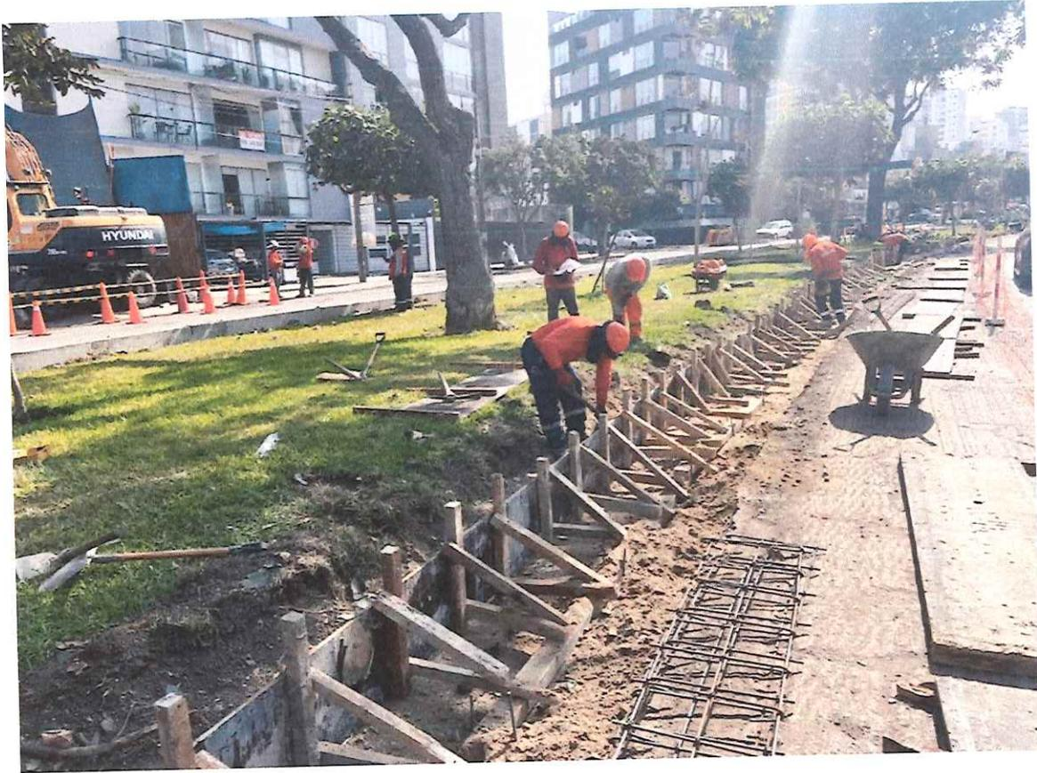
Encofrado de sardinel y control de los niveles en ampliación de vía.
