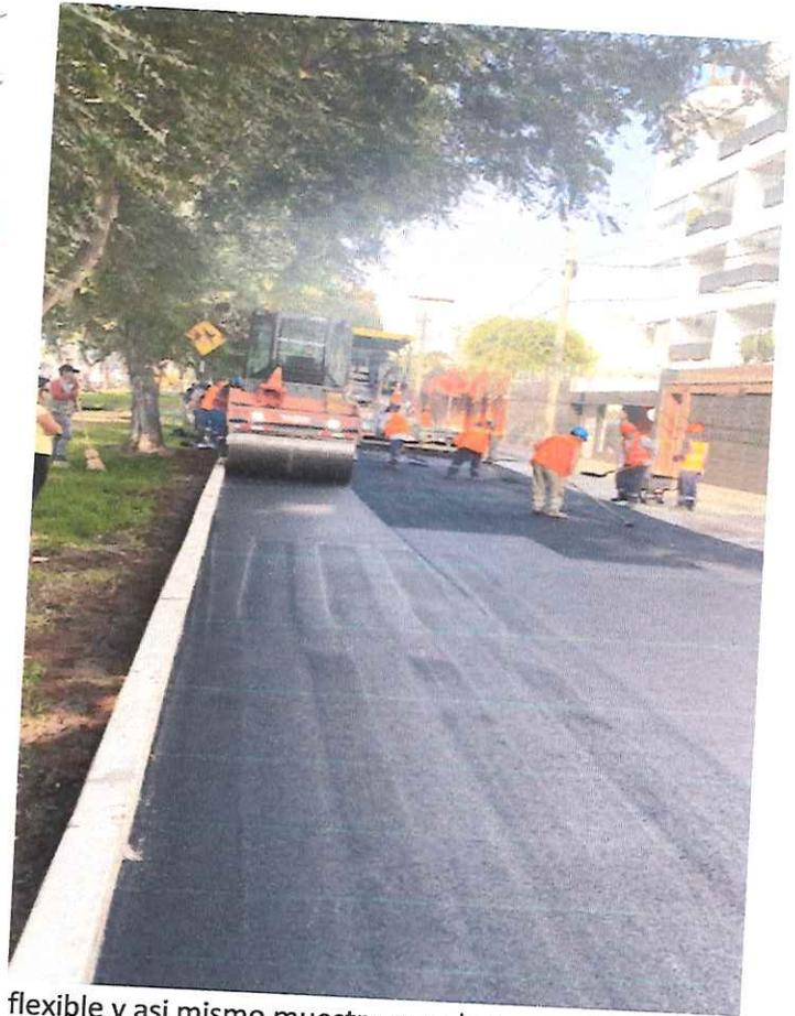
Se aprecian las actividades del tendido del pavimento flexible y asi mismo muestra para los ensayos marshal
