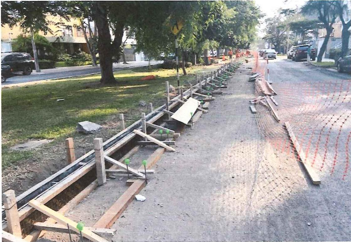
Se aprecia el encofrado y así mismo se toman medidas de seguridad en protecciones colectivas.
