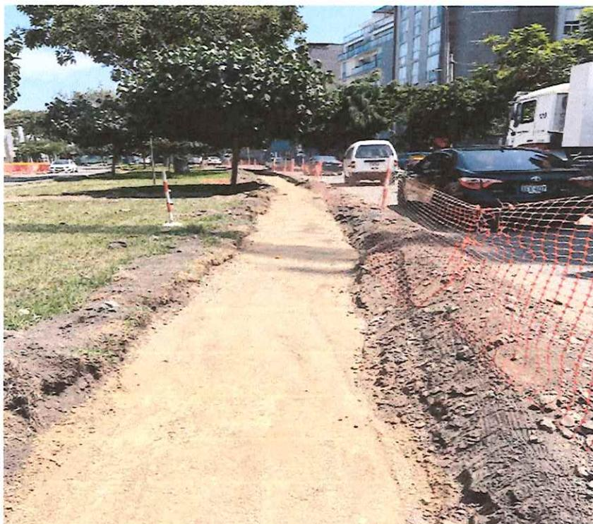
Se aprecia material de préstamo (afirmado) a nivel de base para la ampliación de vía
