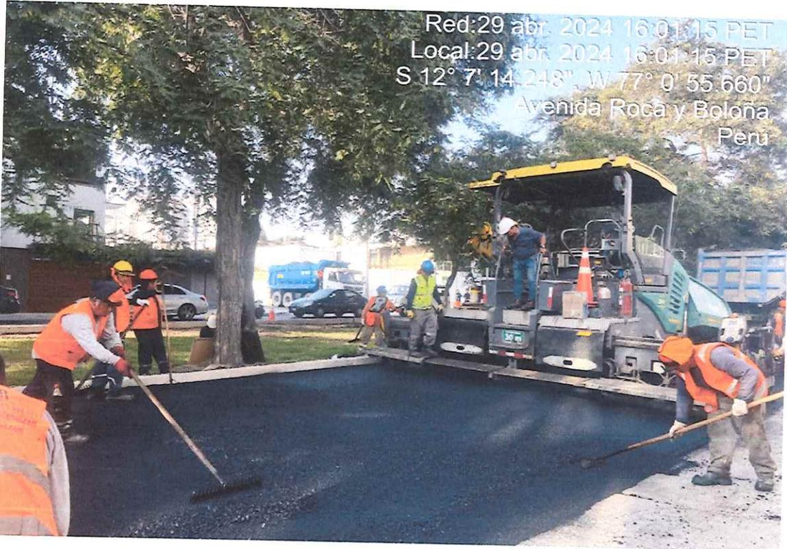
Se aprecia el tren de asfalto con la cuadrilla y así misma colocación del geotextil no tejido.
