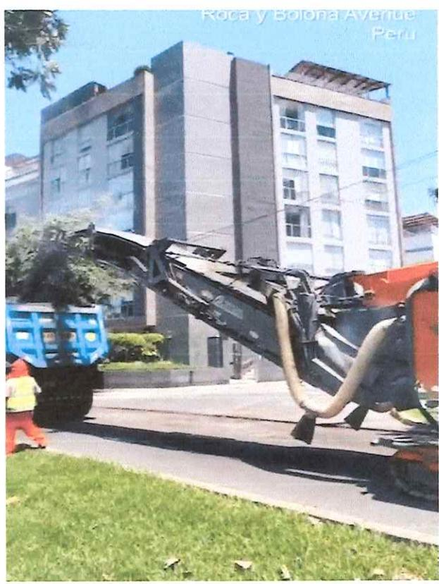
Se aprecia el fresado de la Av. Roca y Boloña y así misma eliminación del fresado y limpieza de calles con la barredora mecánica
