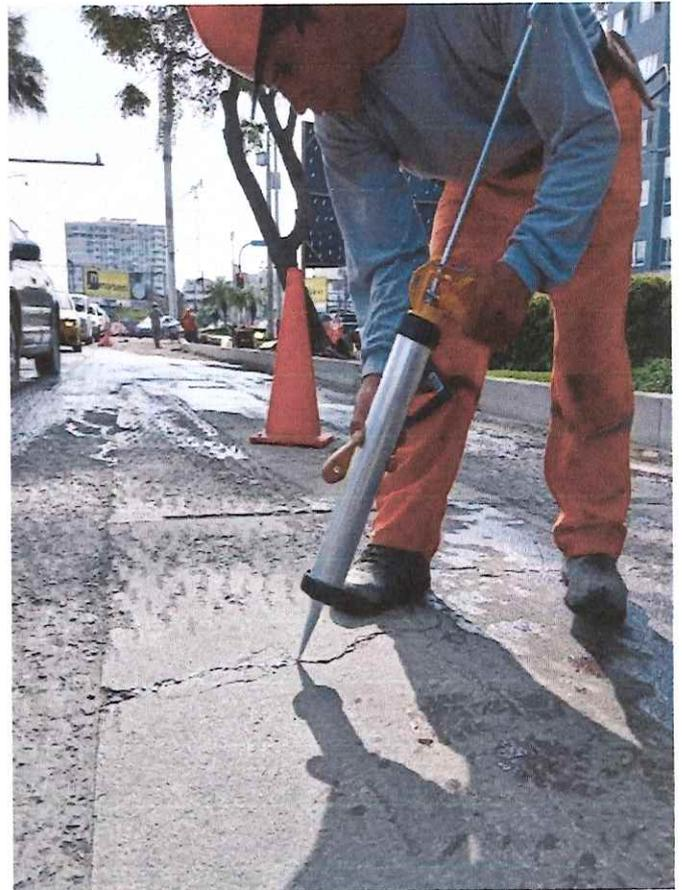
Se aprecia en las tomas fotográficas que se procede al sellado de fisuras en aditivo ELASTOMERICO según indicaciones del expediente técnico.
