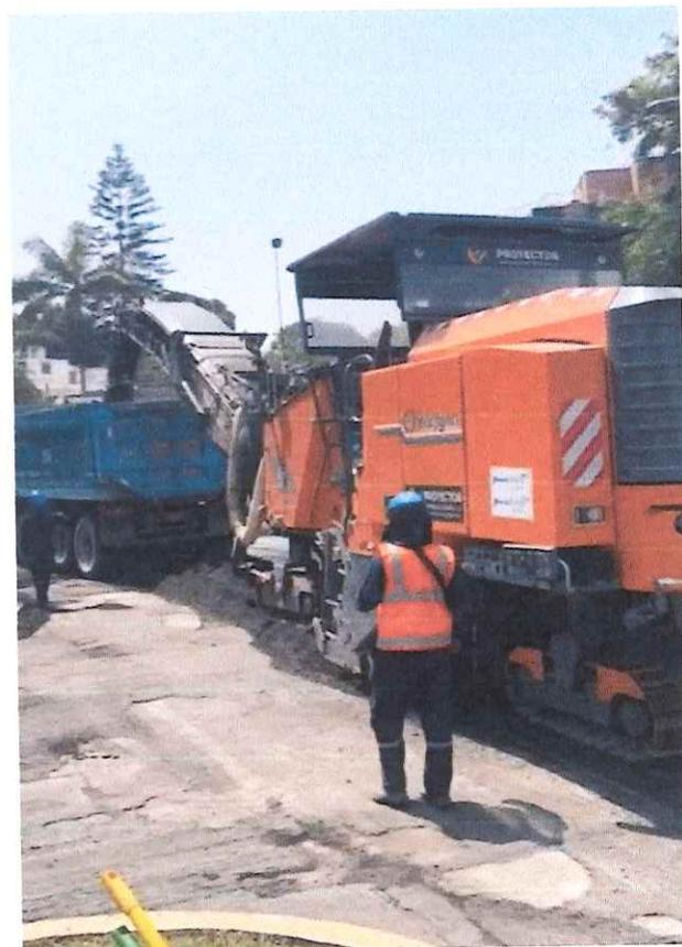
Según las tomas fotográficas se aprecian el fresado de la Av. Roca y Boloña, Lado izquierdo
