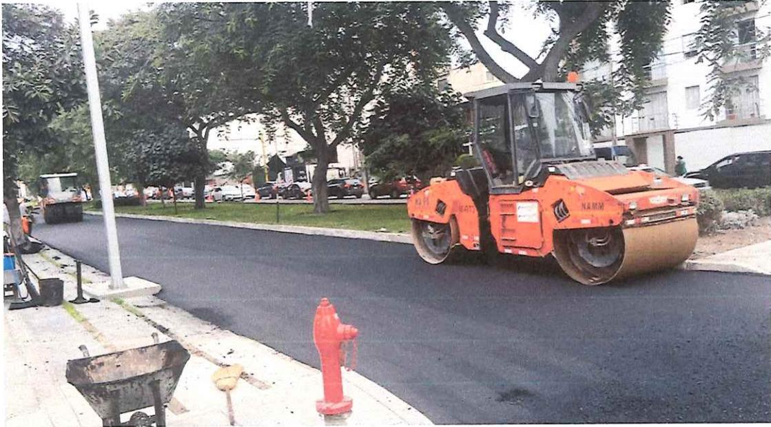
Acabado de la carpeta asfáltica con rodillo tándem y liso y así mismo se continua con el tendido de la carpeta asfáltica de 2", se aprecia la cuadrilla del tren de asfalto.
