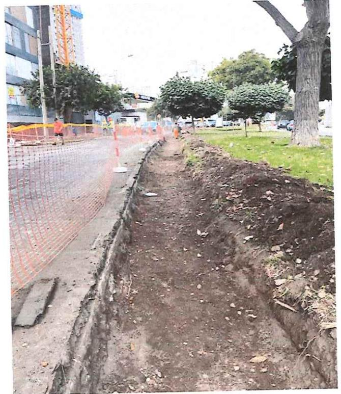
Se aprecia en las tomas fotográficas, curado de vereda de concreto con aditivo membrana curador, así misma compactación de subrasante y tendido de material de préstamo para la ampliación de vía de la cuadra 03 de la Av. Roca y Boloña.
