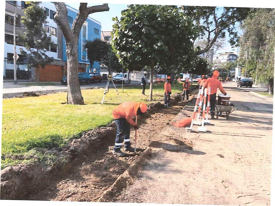
Conformación de material de préstamo y encofrado de sardinel de la ampliación de vía.
