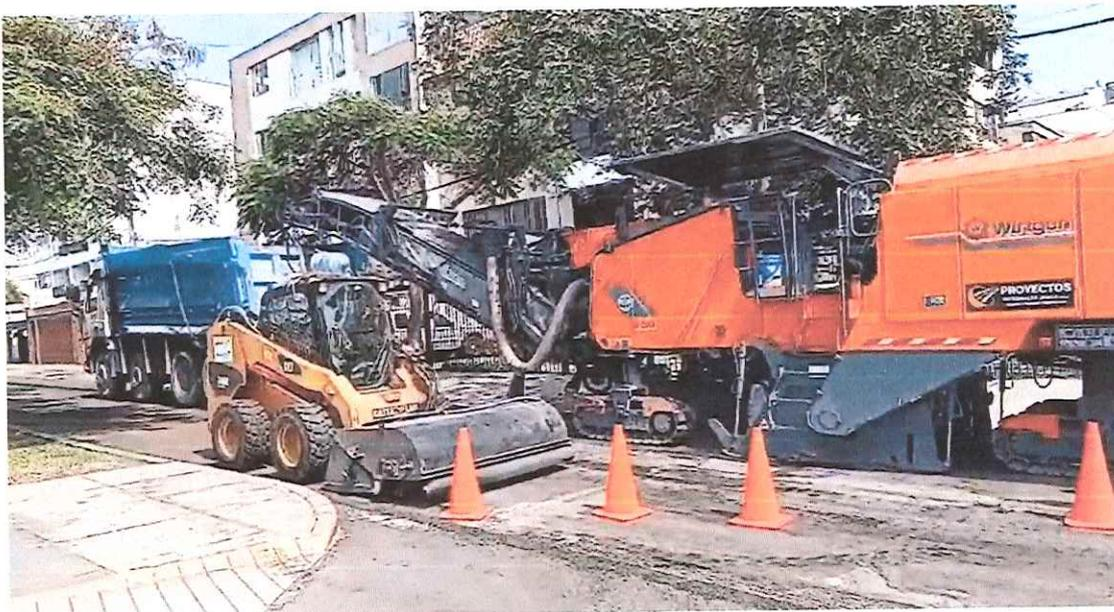
Se aprecia en las tomas fotográficas que se continua con la partida de fresado en Av. Roca y Boloña y así mismo en paralelo trabajos de limpieza con la barredora mecánica.
