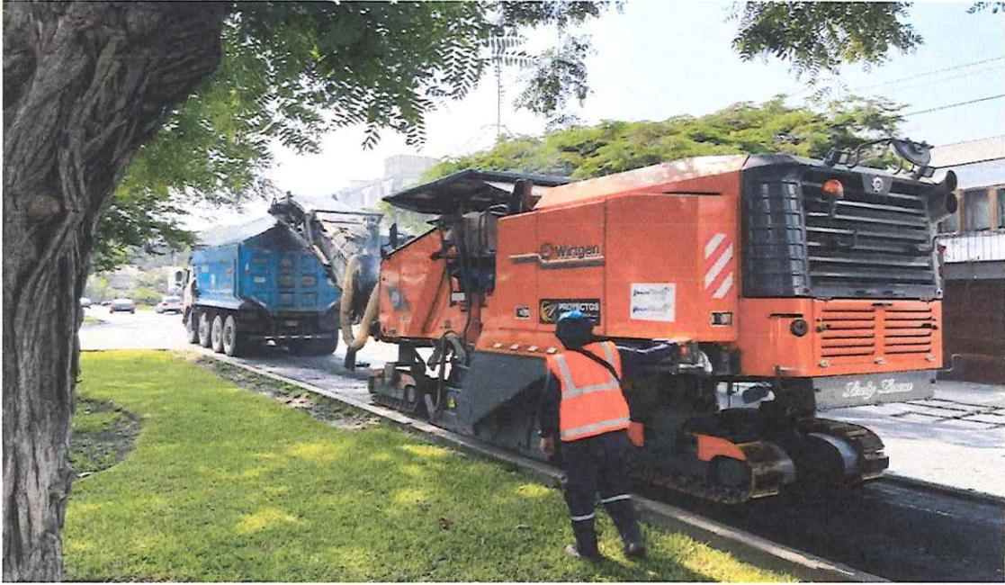
Se aprecia en las tomas fotográficas que se continua con la partida de fresado en Av. Roca y Boloña y así mismo corte del pavimento existente.
