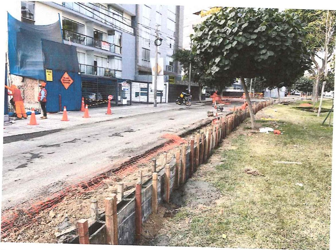
Se aprecia en la toma fotográfica encofrado y vaciado de concreto en sardinel de la cuadra 02 de la Av. Roca y Boloña de la partida ampliación de vía.
