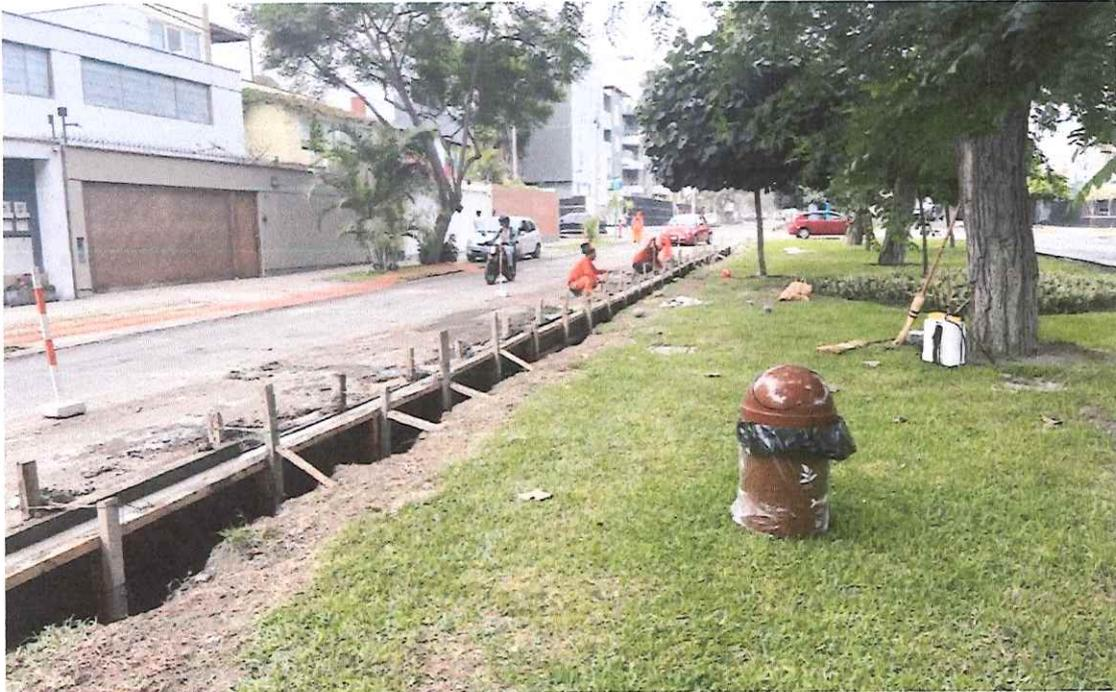
Se aprecia en la toma fotográfica, implementación con tachos de basura para evitar contaminación del medio ambiente, y así mismo encofrado de sardinels.
