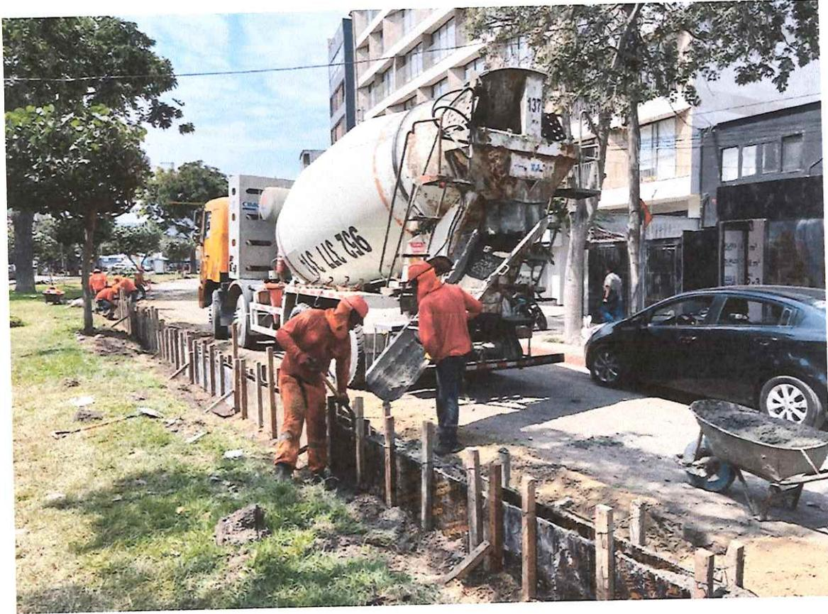
Se aprecia el vaciado de concreto y vibrado para la ampliación de vía.
