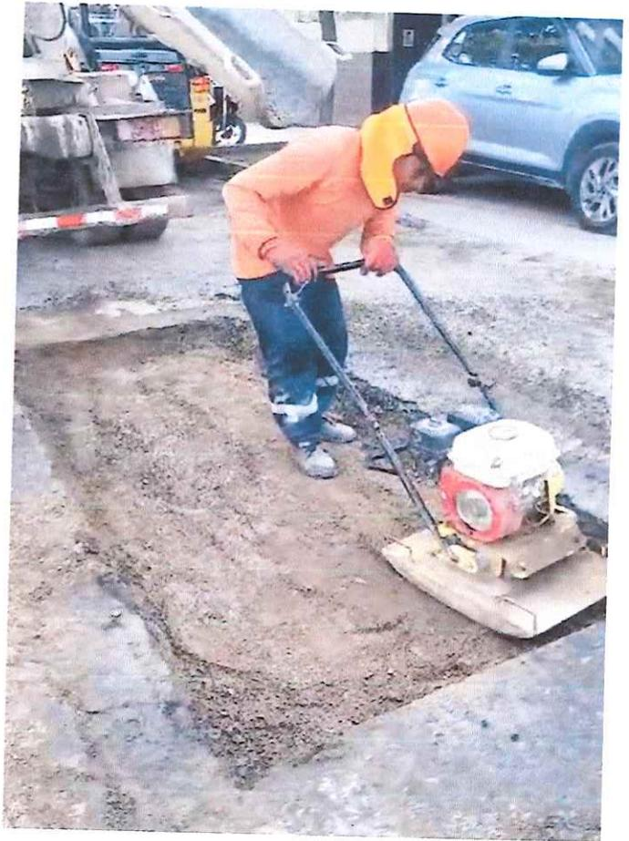
Se aprecia la ejecución de los bacheos profundos y así mismo se procederá en paralelo vaciado de concreto hasta nivel para colocar carpeta asfáltica
