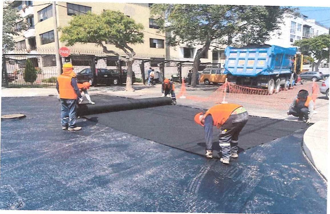
Se aprecia colocación del geotextil para en toda la vía incluido cruces de las calles.
